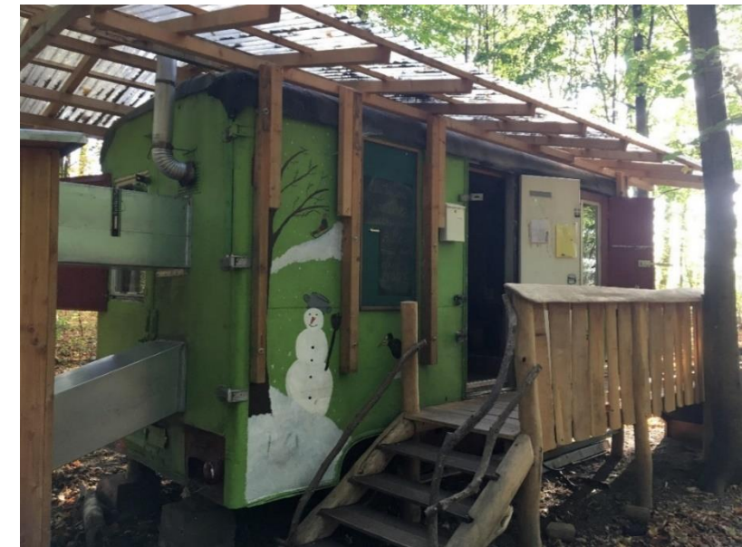
写真5 R園のトレーラーハウス
